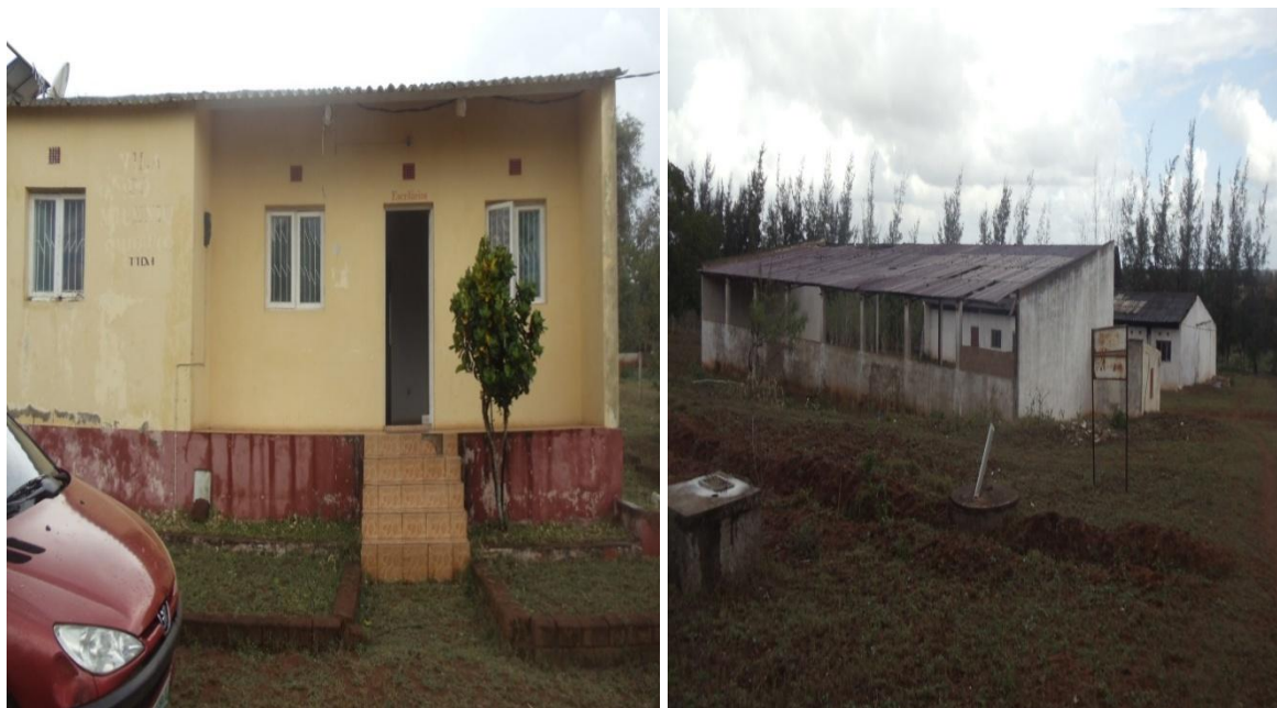
Figura 6 Escritórios e Parque de Maquinas da VMC
