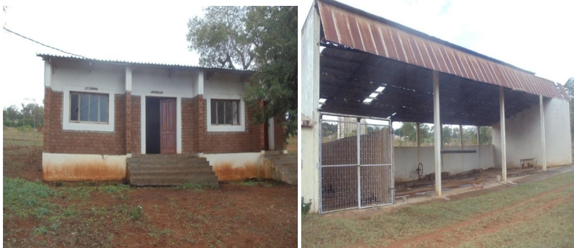
Ilustração 7 Edifício para Centro de Saúde e Alpendre
